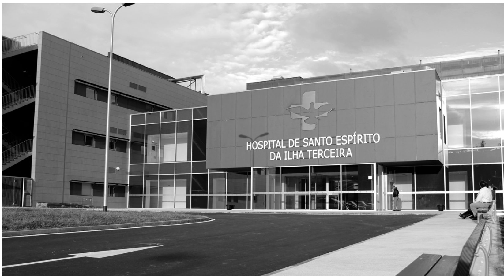
HOSPITAL DA TERCEIRA Medicina nuclear pode estar em risco por alegada falta de canais de comunicação
